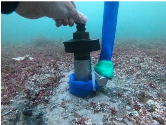
Photos 5 & 6 : Pied de l'ancrage foré
