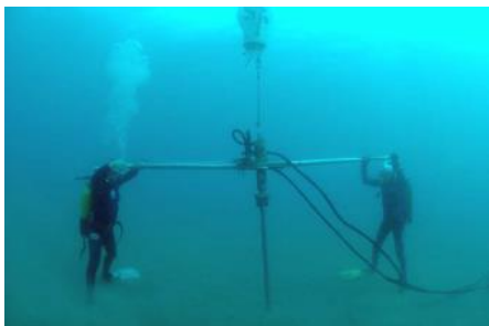
Vissage hydraulique (Neptune Environnement)
